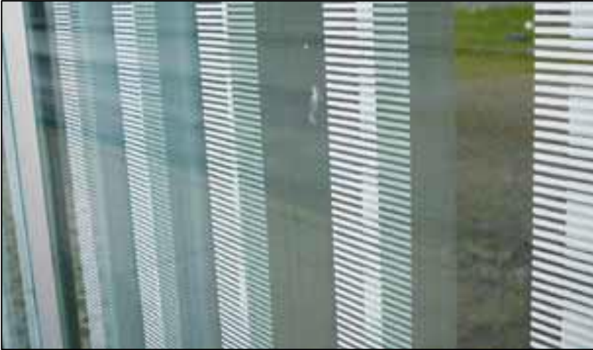
Abbildung 4: Siebdruck auf Glasfläche (Quelle: LINDEINER et al. 2010) 2 cm breite unterbrochene Streifen in 10 cm Abstand – wurde beidseitig aufgebracht und teilweise auf der Rückseite etwas verbreitert, was bei der Annäherung den 3D-Effekt verstärkt
