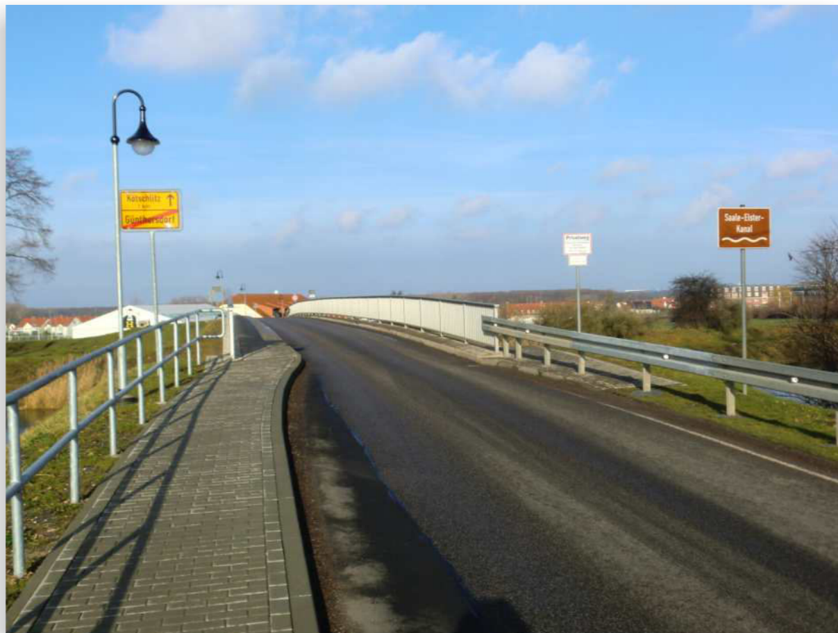
Abbildung 51 Saale-Elster-Kanalbrücke bei Kötzschlitz nahe des EKZ Günthersdorf Quelle: LA DÄRR; 22.01.2011
