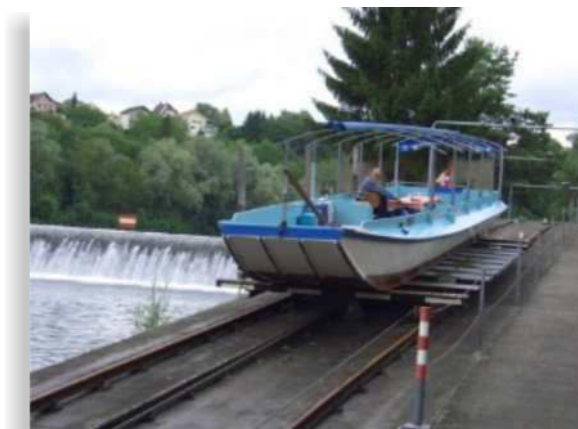
Abbildung 11 Weidling (Flachboot) auf dem Rollberg am Kraftwerk Rheinau in der Schweiz Quelle: Verkehrsverein Eglisau (Schweiz); Website http://www.verkehrsverein-eglisau.ch
