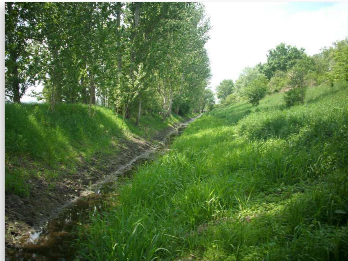
Abbildung 54 Ableiter vom Vorfluter „Der Bach“ nahe Wüsteneutzsch zur Saale (parallel zum Elster-Saale-Kanal); seine Aufnahmefähigkeit ist auf Grund der zu knapp dimensionierten Heberanlage in die Saale sehr begrenzt; Quelle: DÄRR LA; 13.05.2011
