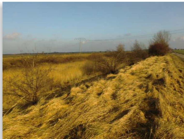
Abbildung 32 Baulich begonnener, nicht gefluteter Kanalabschnitt bei Zscherneddel Quelle: LA DÄRR; 22.01.2011
