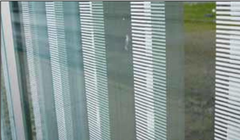
**Abbildung 4: Siebdruck auf Glasfläche (Quelle: LINDEINER et al. 2010)**
